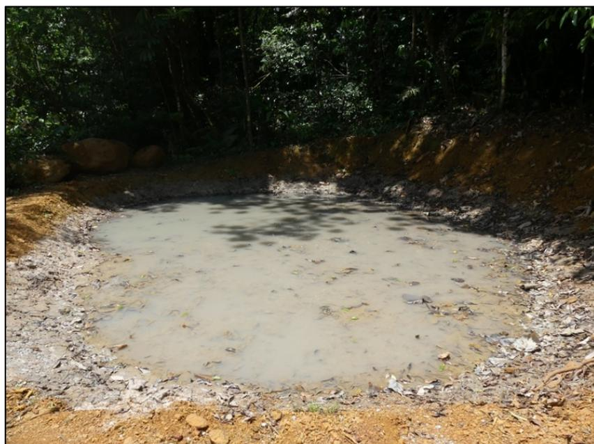
L'étanchéité de la mare a été rendue possible par la mise en place d'une couche d'argile sur le fond et les bords du bassin. Cette argile a été extraite depuis une carrière en Guyane exploitée par l'opérateur à l'origine des travaux.
