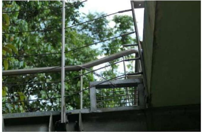
Figure 5 : Nouvelle détérioration d'un câble de sécurité sur la passerelle d'accès au toit (© Association Trésor)
